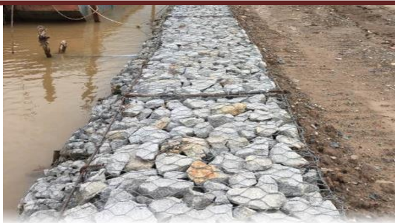
Hình: Kè bảo vệ bờ sông bằng rọ đá
